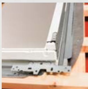
Теплоізоляційний контур надійно утеплює периметр вікна
